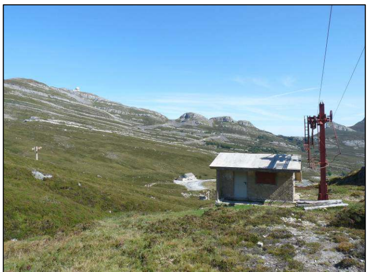
Instalaciones de la estación de esquí de Lunada, con la caseta de motores de uno de los remontes en primer plano 1 .
