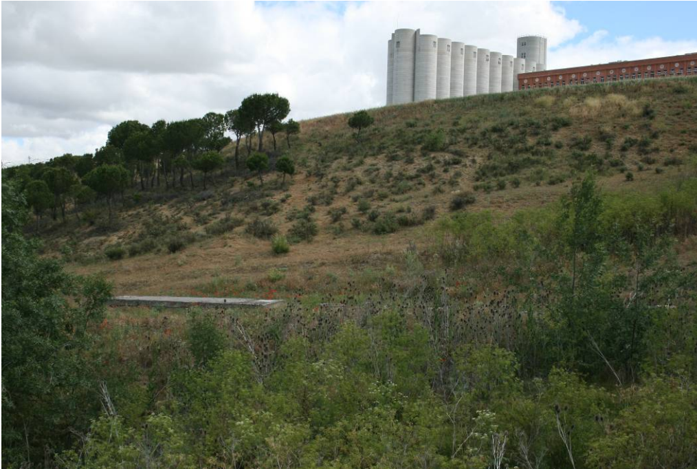
Fotografía 1. Aspecto general de la situación de la población situada en la ladera del río Adaja, con la repoblación de Pinus pinea y las infraestructuras próximas derivadas de las instalaciones ferroviarias, en la localidad de Arévalo (Ávila).
