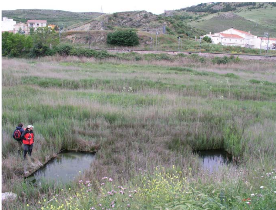
Foto 8. Áreas excavadas, ahora inundadas, para un estudio geotécnico destinado a la ubicación de los pilares de un puente en la autovía.
