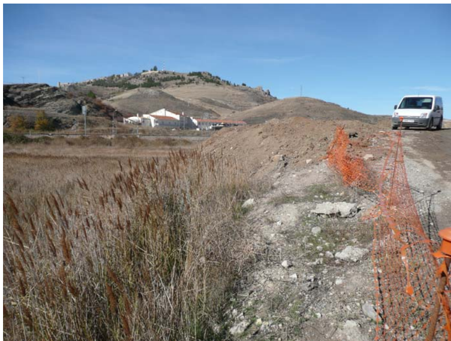
Foto 9. Terraplén de una pista para vehículos bajo una de los dos únicos grupos de Glaux maritima . Algunos desprendimientos que se producen afectan a este grupo poblacional en Salinas de Medinaceli.
